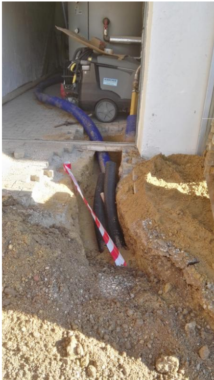
Verlegung Fernwärmeleitung
